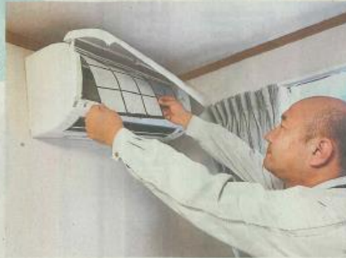
エアコンフィルターの清掃作業をする杉本さん（浜松市内）
